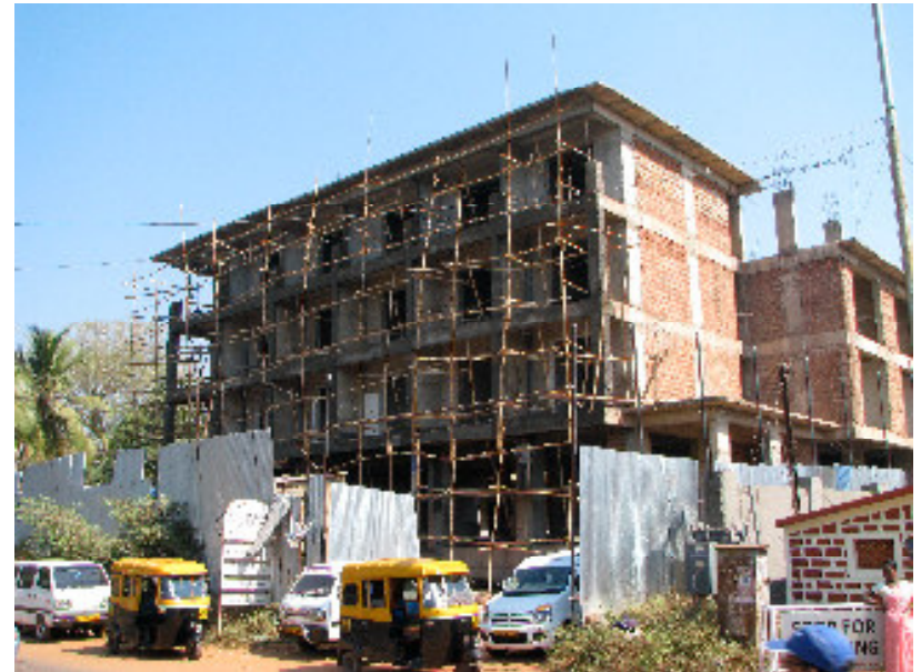
Cóż to za systemowe rusztowanie budowlane?
